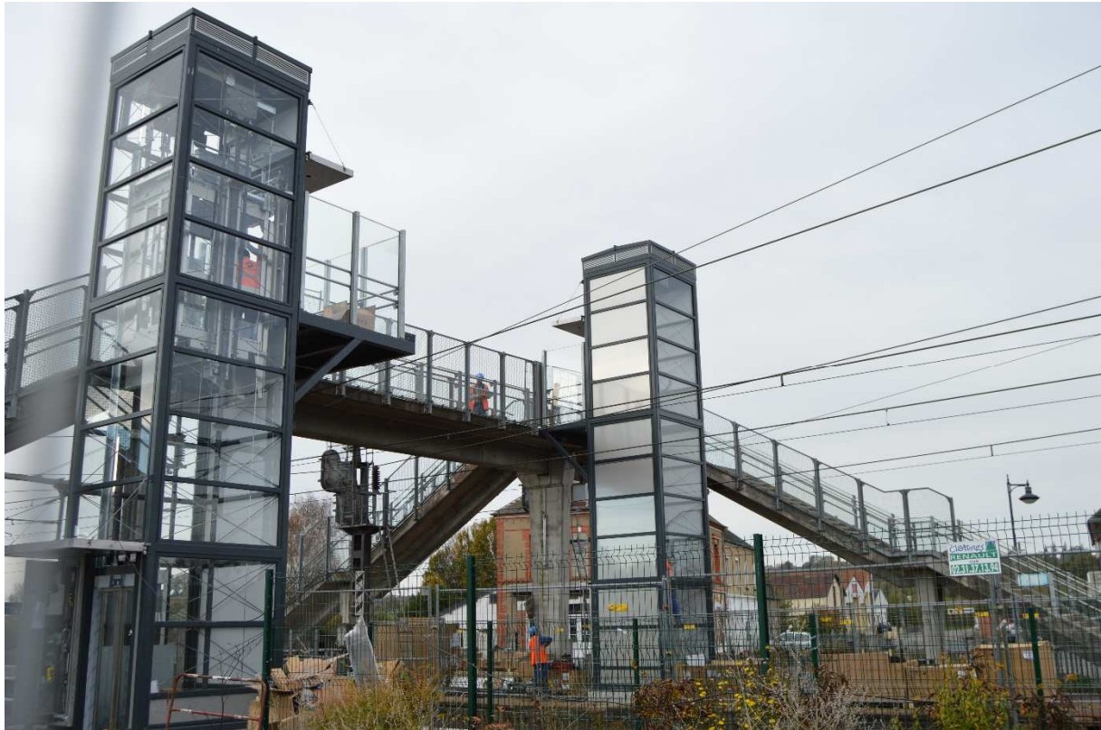
Travaux d'installation des cabines d'ascenseurs de la passerelle en gare de Lison.
