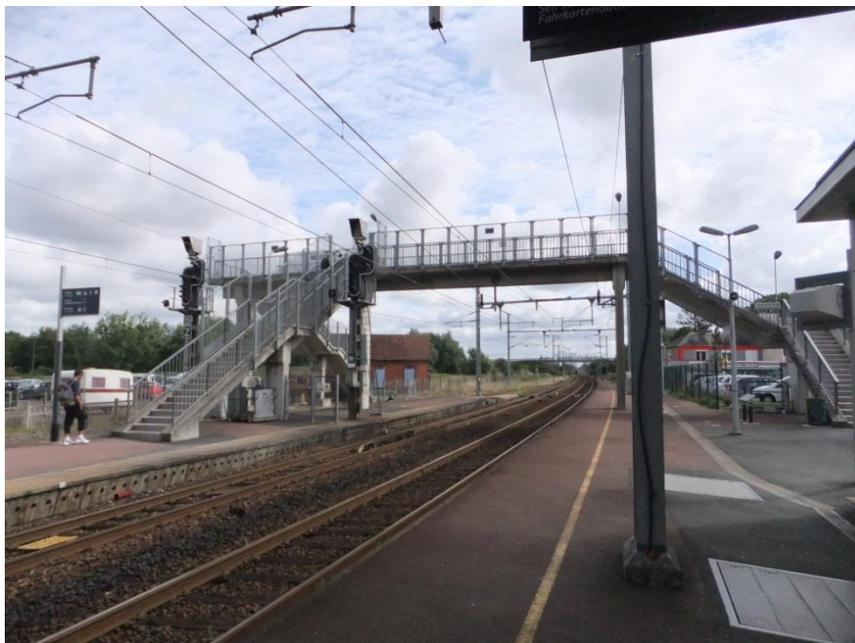
Pour la passerelle, seront installés deux ascenseurs pour permettre aux personnes, notamment à mobilité réduite, de franchir les voies entre les deux quais et prendre le train en évitant de monter puis de descendre les escaliers pénibles ; ces ascenseurs sont prévus pour une charge de 800 kgs avec 4 côtés vitrés. Ainsi du parking au train, en passant par le bâtiment de la gare aménagé également, un cheminement complet pour les PMR (personnes à mobilité réduite) sera réalisé pour l'automne 2014.
