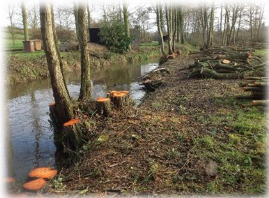
Travaux de restauration de l'Elle près du Moulin Hébert et de la pisciculture.
