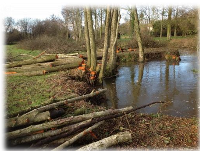
Travaux de nettoyage des berges
