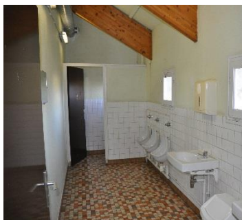
Les sanitaires avant travaux
